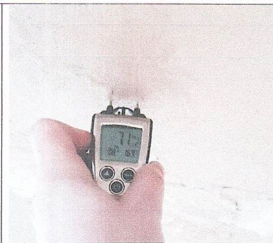
Эвакуационные балконы – замер влажности бетонной плиты
